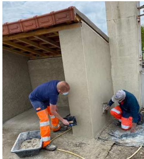
Nos agents communaux et intercommunaux posent l'enduit sur le nouvel abri du cimetière.
