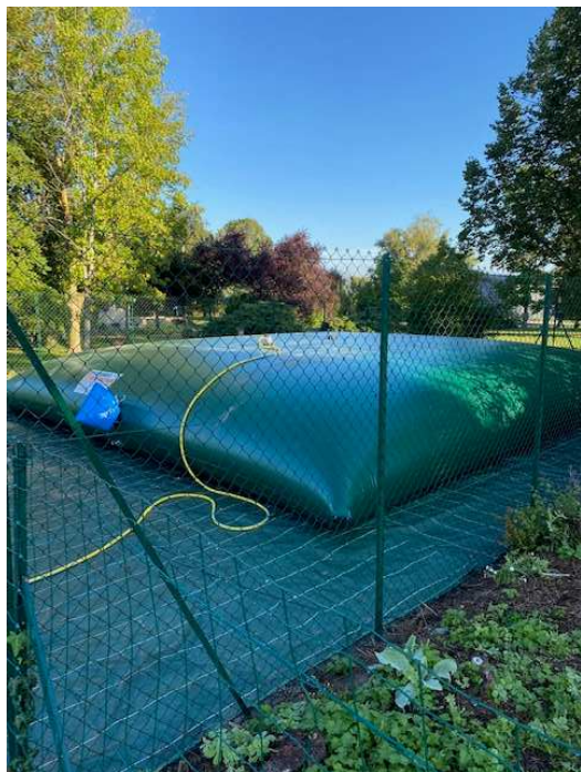
La citerne de 60m 3 en cours de remplissage.
