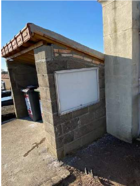
Le petit toit a été refait et rehaussé. Le panneau d'affichage a été remplacé.
