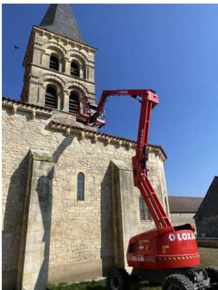
Le 5 mars 2022, M. Victor Auvray, tailleur de pierre, a effectué le remplacement du socle et de la colonnette du clocher.
