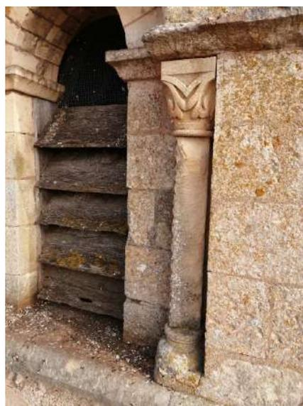
Au fil du temps, de nombreux dommages ont affecté notre église. Le calcaire utilisé pour sa construction finit par s'éroder. Dans l'objectif d'un programme de restauration une étude sera bientôt menée, mais en attendant, il était nécessaire de réaliser des travaux de sécurisation. En effet, un socle et une colonnette encadrant les baies géminées étaient en très mauvais état.
